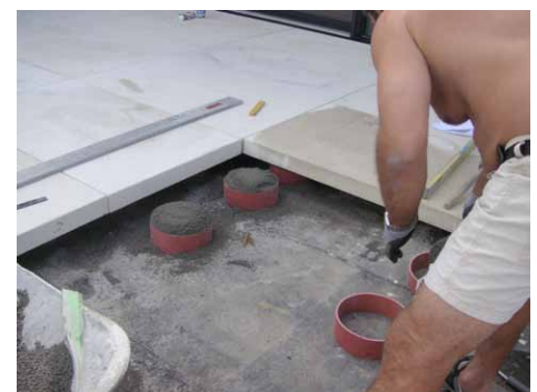
Verlegung auf Punktauflager
