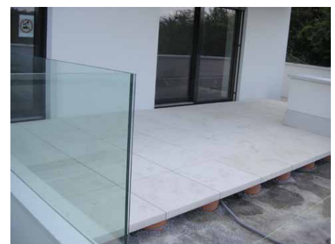
Verlegung auf Punktauflager
