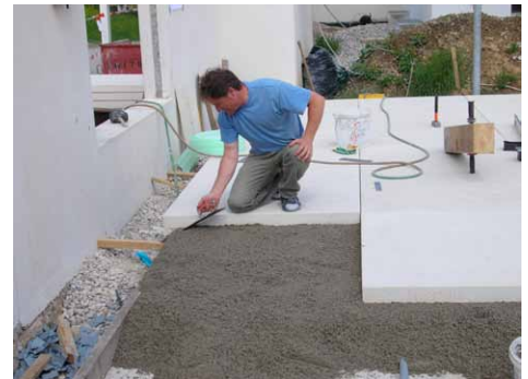
Verlegung vollflächig im Drainagebeton ( oder im Splittbett )
